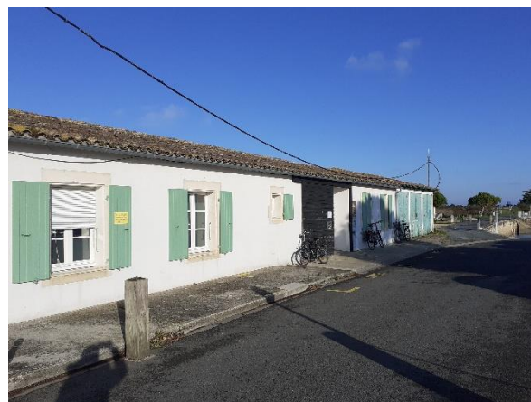
Photo 2: cabinet médical déjà réhabilité au cœur de la Criée
