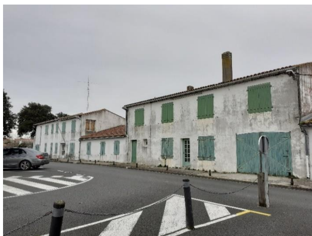
Photo 1: Bâtiment A et B au Sud
