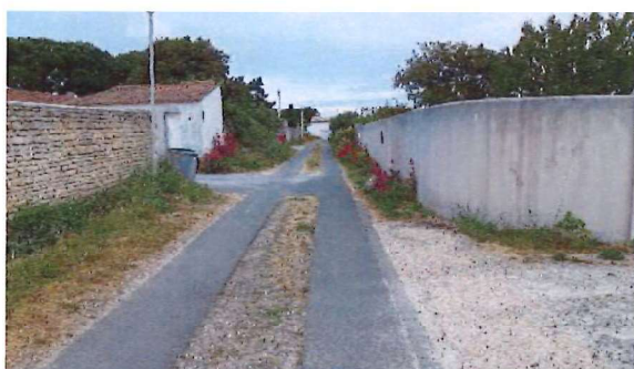
Massif enterré sous voirie - Rue des Minées
