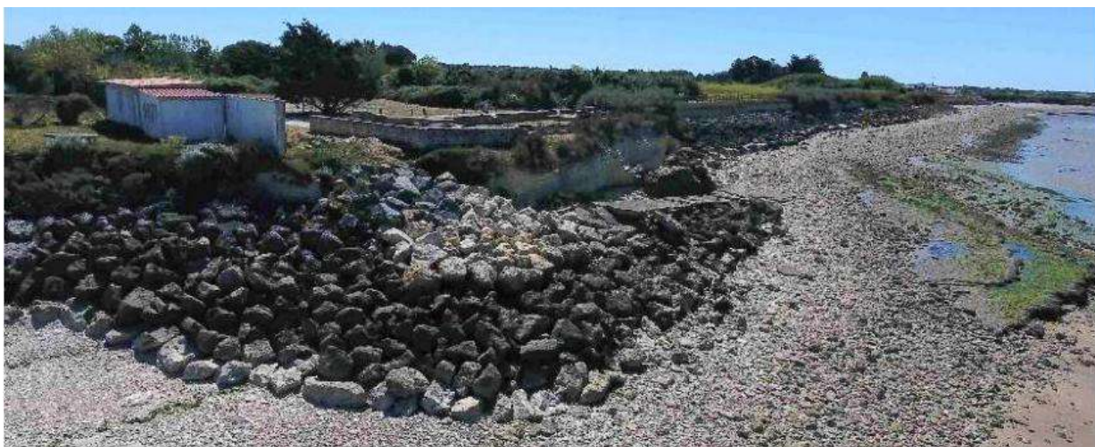
Falaise de Saint Martin protégée par des enrochements (Observatoire du littoral & CASAGEC, 2024)
