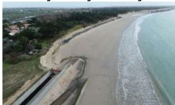
Ouvrage maçonné et enrochement du Bouillon
