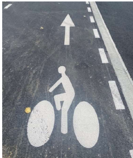
Exemple de signalétique directionnelle horizontale
