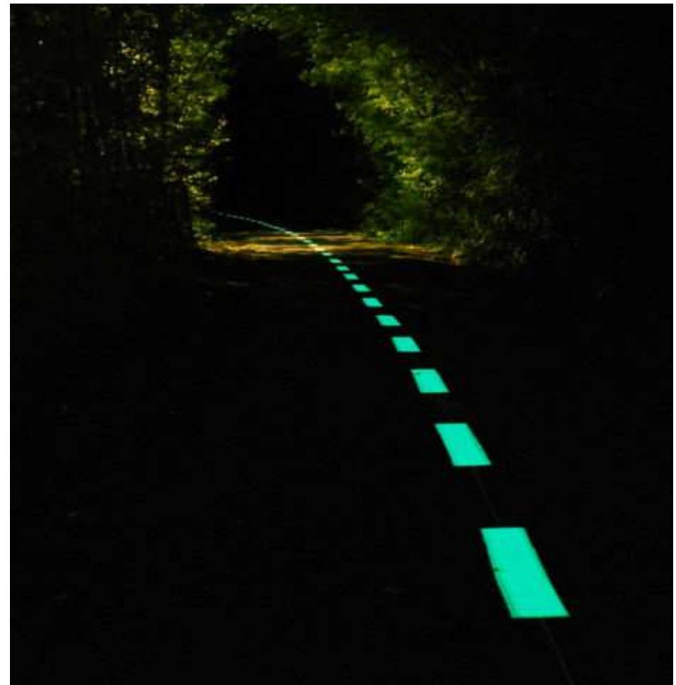
Exemple de peinture photoluminescente Lumnikrom®
