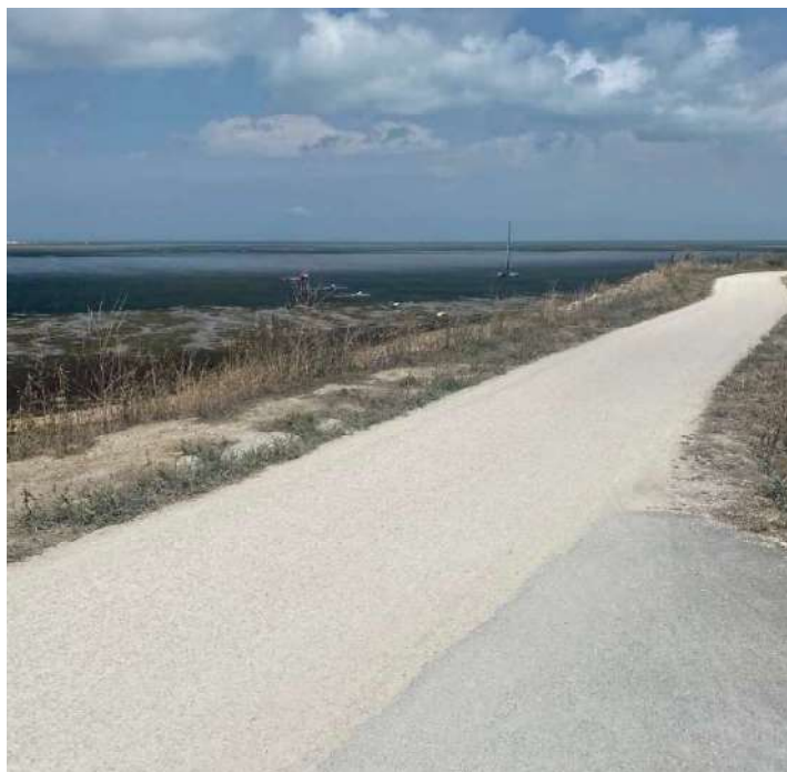
Revêtement en stabilisé calcaire, piste cyclable St-Martin-La Couarde
