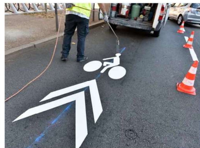
Nouvelle signalisation, marquage au sol pour les cyclistes. Photo Hervé Chellé © Hervé Chellé
