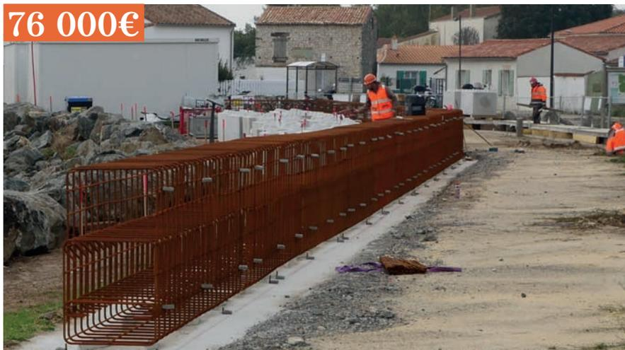
Ils prévoient la construction d'un muret d'1m à 1m 30 de hauteur, situé en arrière des enrochements, et sur un linéaire d'environ 355 mètres. La participation de la CdC (76 000 €) représente 20 % du montant total des travaux.
