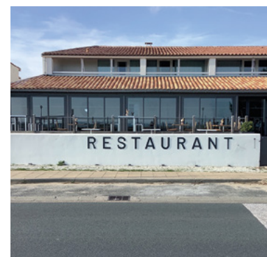
Enseigne sur clôture en lettres découpées
