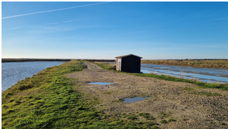
Bâtiment salicole, Loix, décembre 2021
