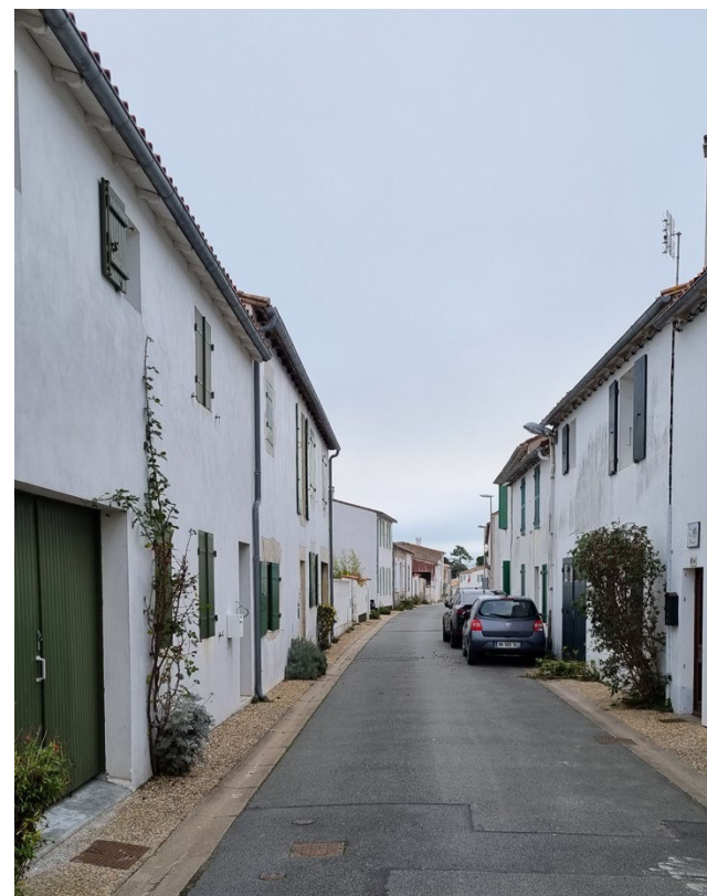
Façades enduites, Rivedoux-Plage, décembre 2021
