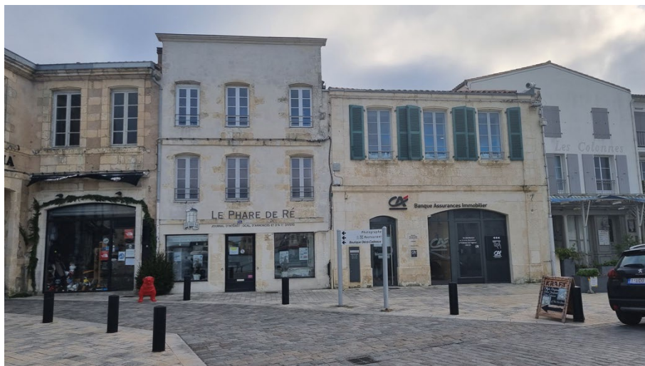
Activités en rez-de-chaussée et habitat à l'étage, Saint-Martin-de-Ré, décembre 2021
