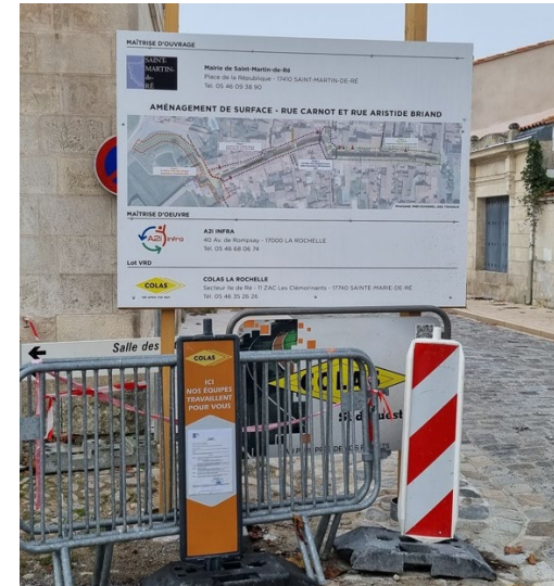
Enseigne temporaire scellée au sol (travaux), Saint-Martin-de-Ré, décembre 2021
