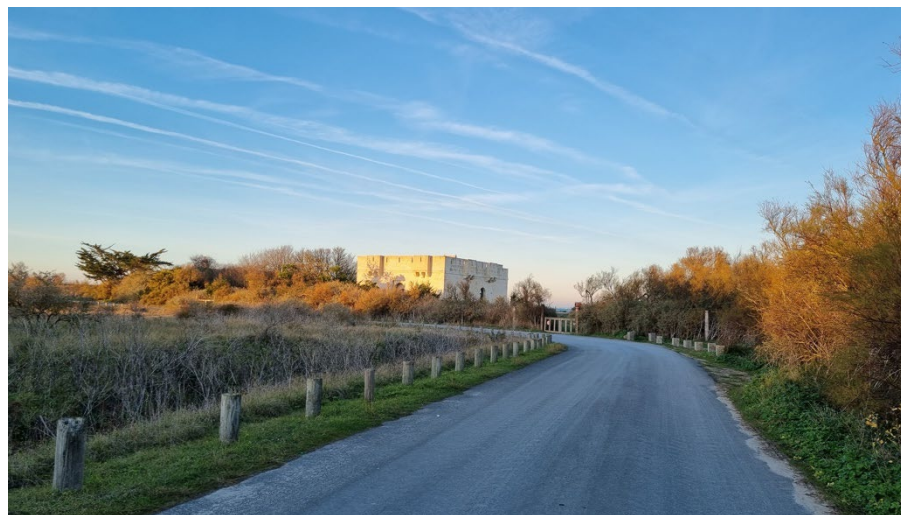
Fort du Grouin, Loix, décembre 2021
