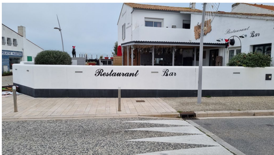
Enseigne parallèle à un mur de clôture, Rivedoux-Plage, décembre 2021
