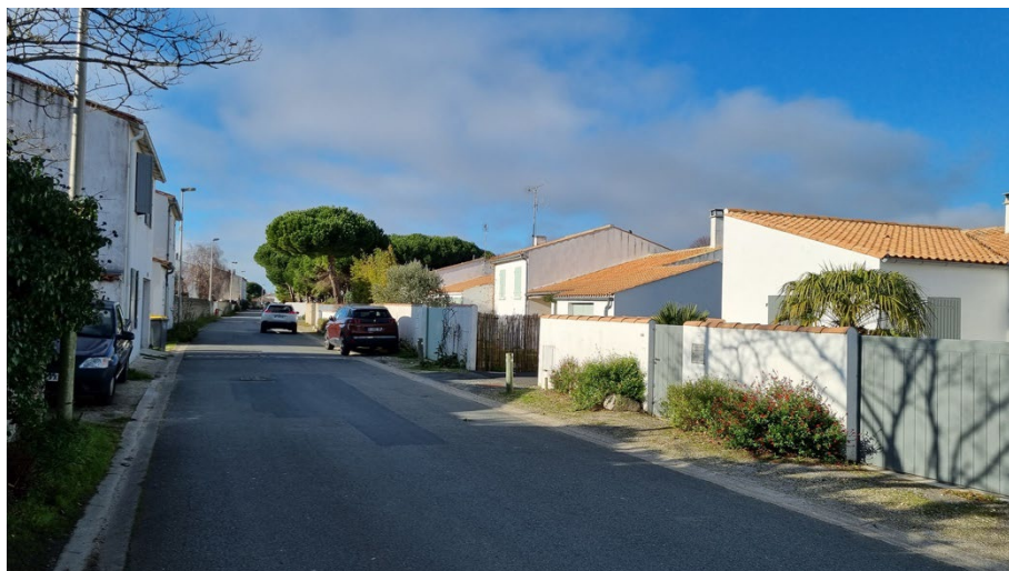
Toitures en tuile, Le Bois-Plage-en-Ré, décembre 2021
