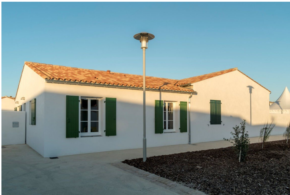
Logement à loyer modéré de Loix au sein du lotissement « La Cure ». Crédit photographique : ©Yann Werdefroy
