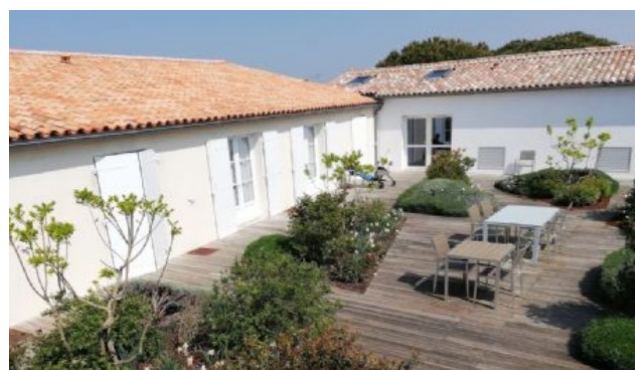
EHPAD La Tonnelle à Sainte-Marie-de-Ré // Source : site lesmaisonsderetraite.fr
