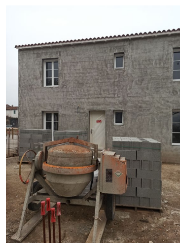
Construction en cours à la Flotte-en-Ré. Crédit photographique : MERC/AT
