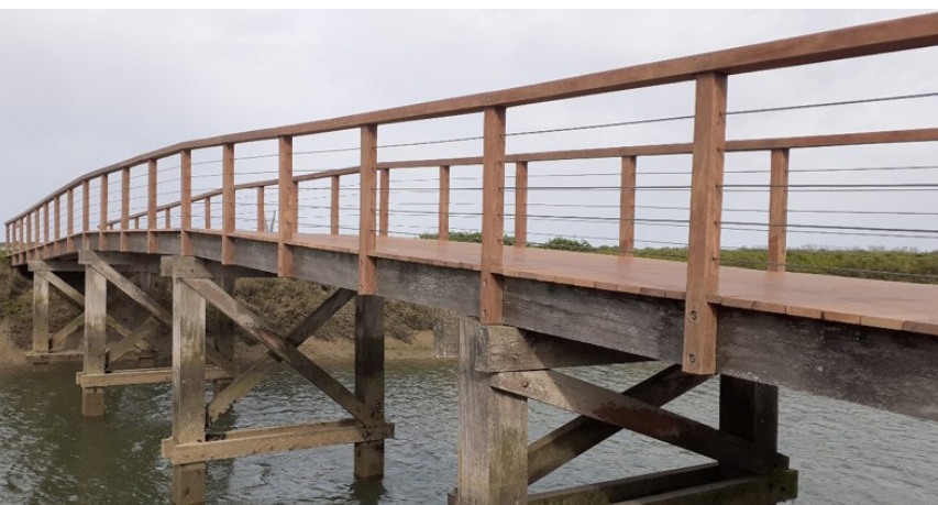
Travaux de la passerelle Lilleau des Niges
