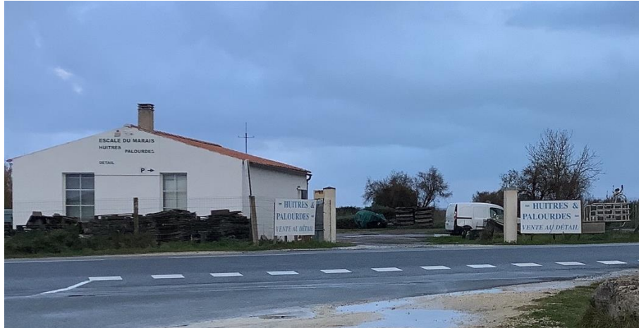
Bâtiment conchylicole situé hors agglomération, Loix, décembre 2021
