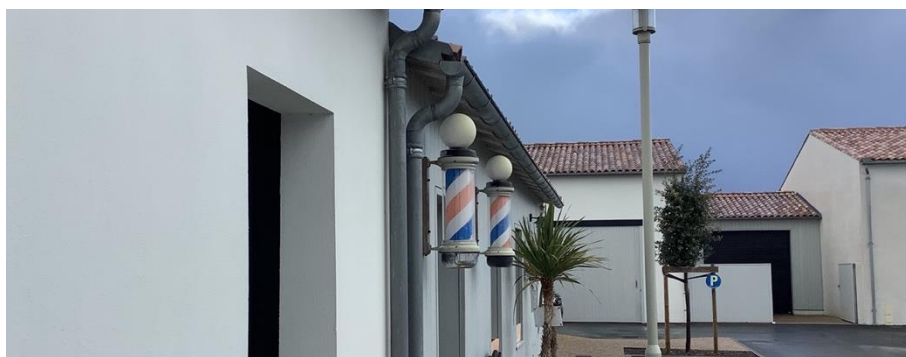
Enseignes perpendiculaires au mur (nombre = 2 par façade), Loix, décembre 2021
