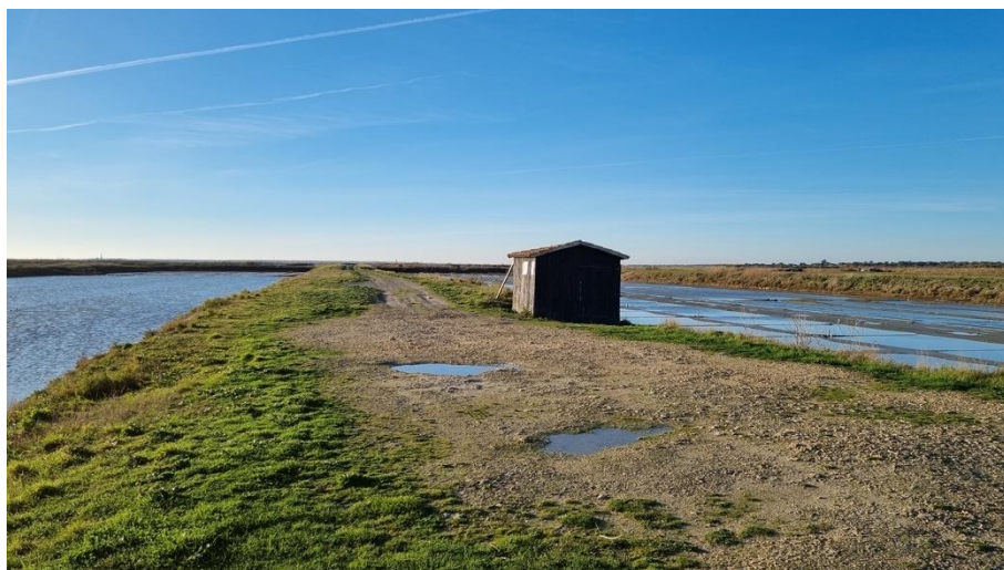
Bâtiment salicole, Loix, décembre 2021
