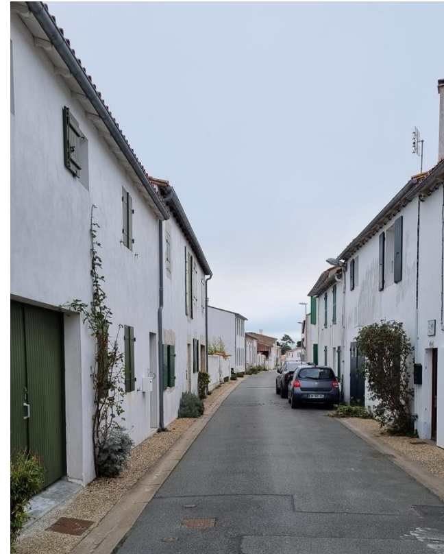
Façades enduites, Rivedoux-Plage, décembre 2021
