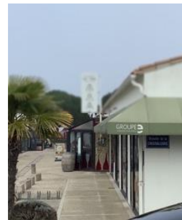
Enseigne perpendiculaire dépassant la limite haute du mur, décembre 2021
