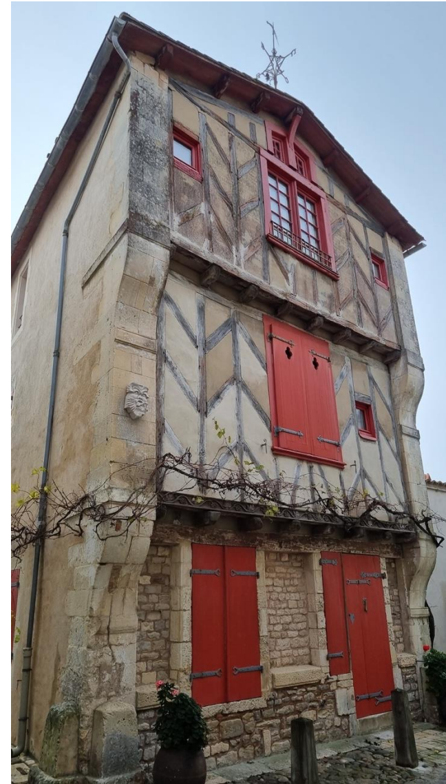
Maison dite de la Vinaterie (monument inscrit), Saint-Martin-de-Ré, décembre 2021
