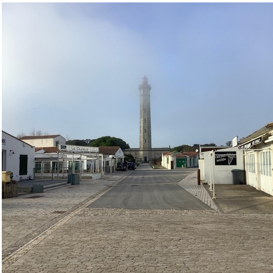
Phare à terre des Baleines, Saint-Clément-des-Baleines, décembre 2021
