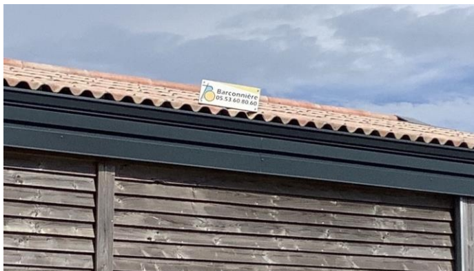
Enseigne sur toiture. Ile-de-Ré 2021
