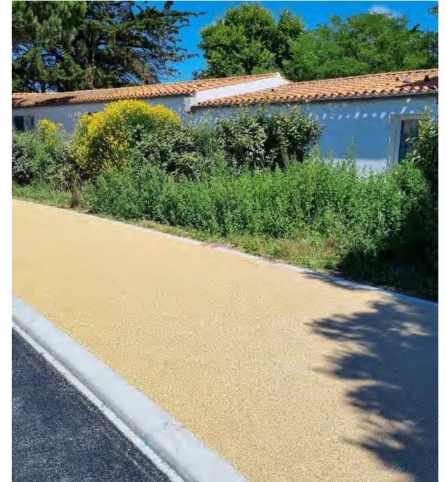
Revêtement Urbanlith, piste cyclable Ars-en-Ré
