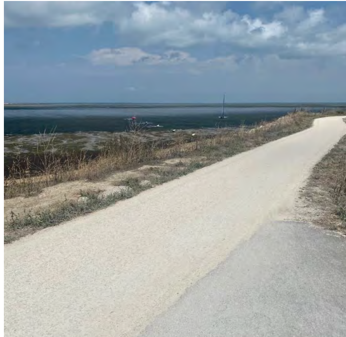
Revêtement en stabilisé calcaire, piste cyclable St-Martin-La Couarde
