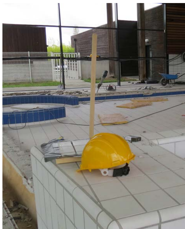
Les travaux de la piscine Aquaré.
