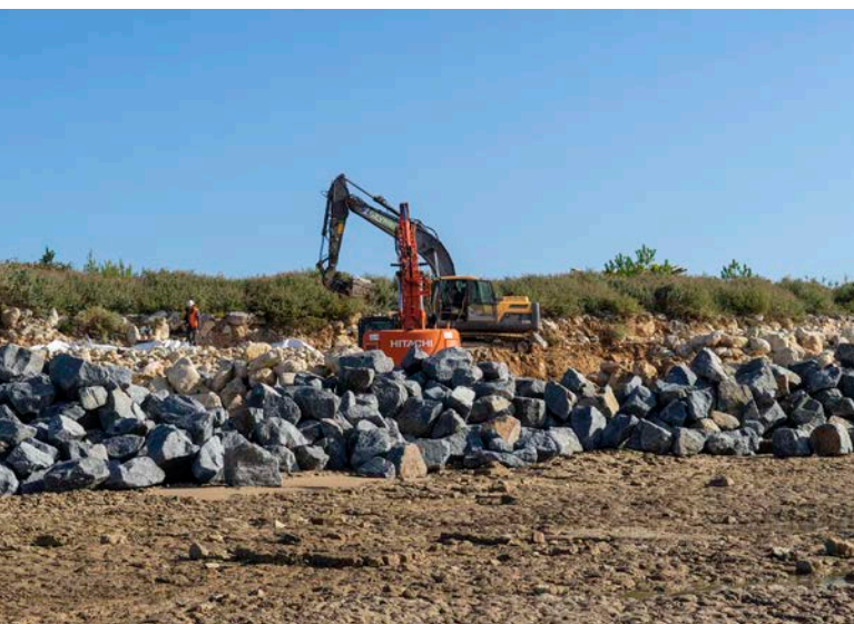
Travaux de défense des côtes
