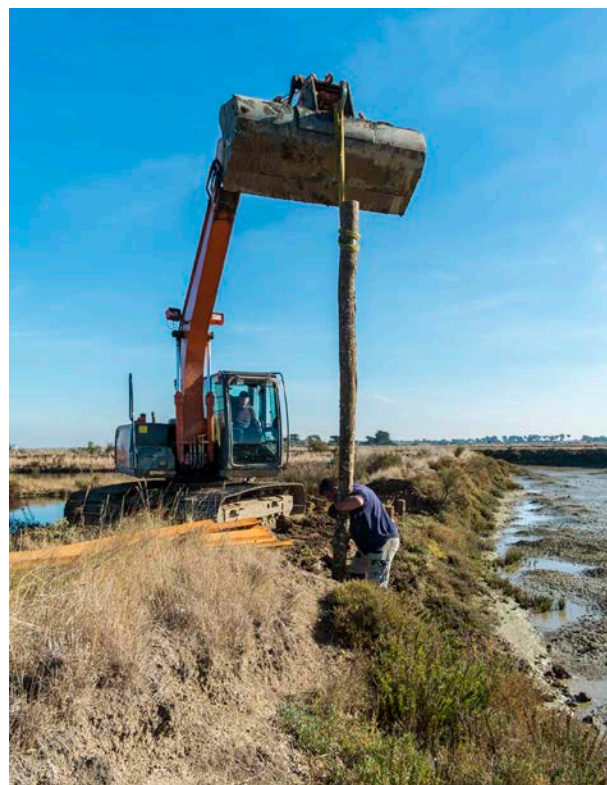
Travaux de protection des berges
