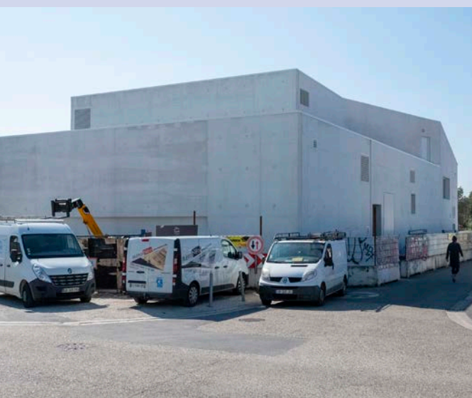
Chantier de La Maline à La Couarde-sur-Mer
