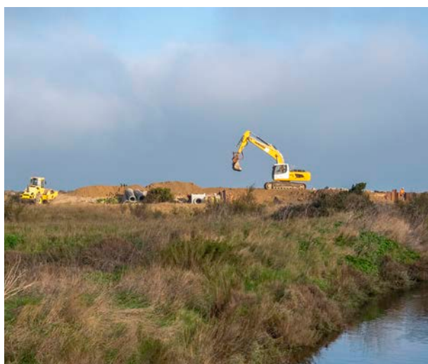
Renforcement des enrochements
