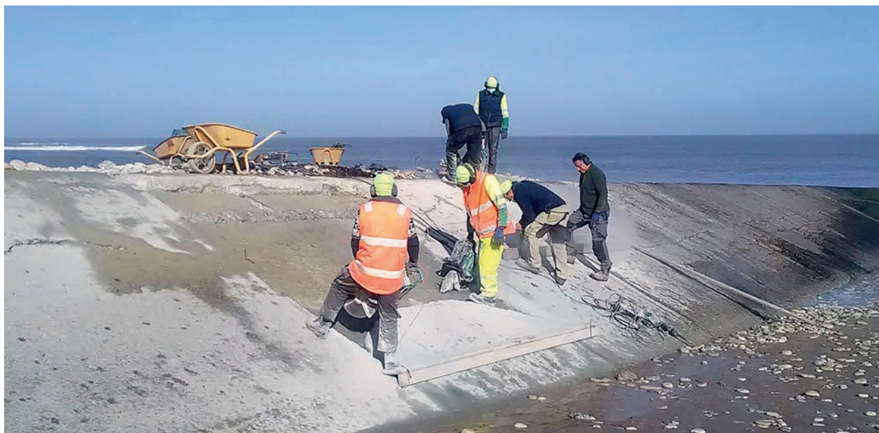
La brigade des digues
