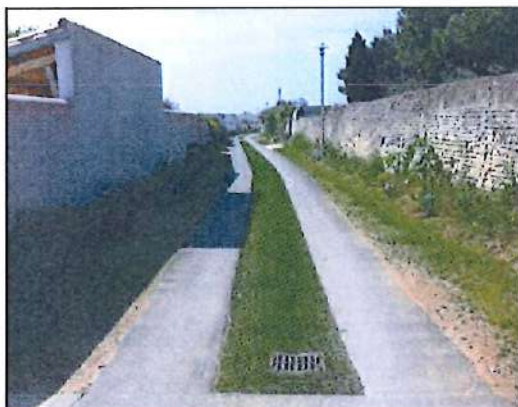
Figure 1 : vue de la rue des Minées et de son système de collecte des eaux pluviales original
