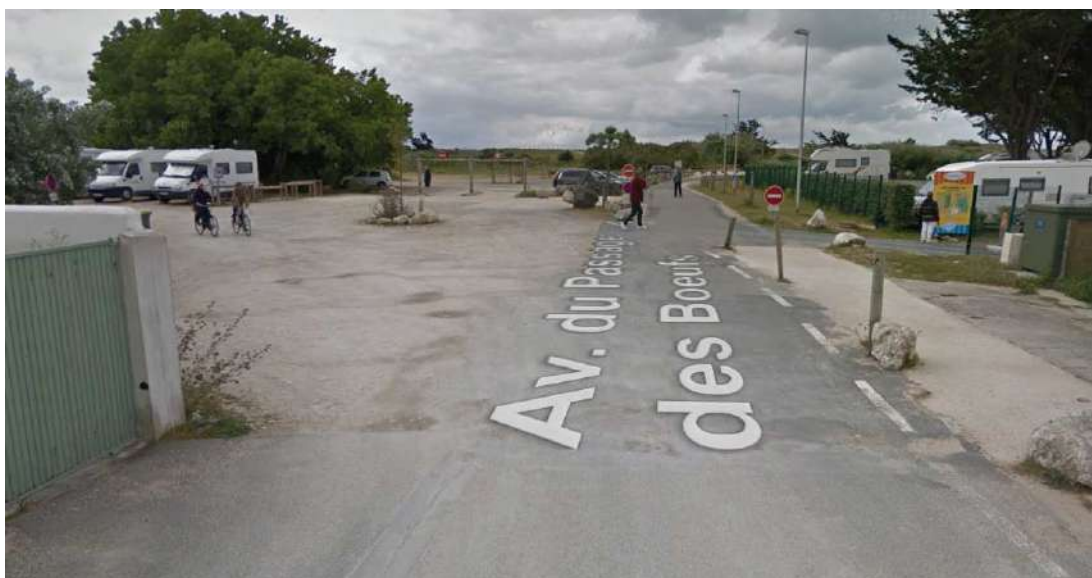
Figure 11 : vue du parking en amont de rejet du refoulement pluvial en mer av. du Passage aux Boeufs
