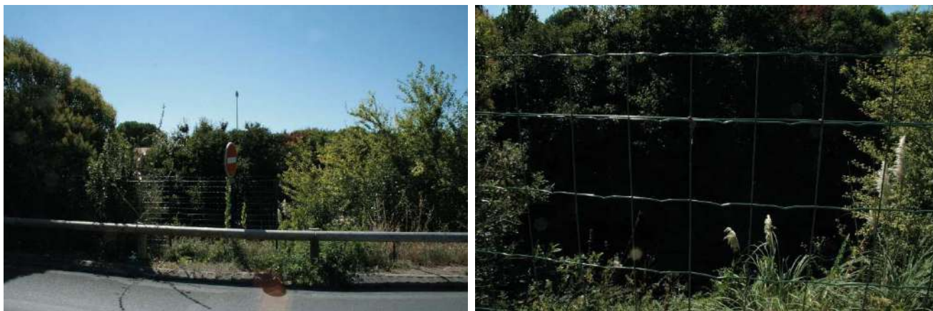
Figure 8 : vue du bassin d'infiltration exutoire du SBV « Rue Chef de Ville »
