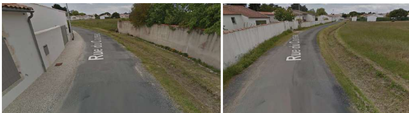
Figure 7 : Vue du fossé drainant le secteur de Mille Fleurs (Le Courseau)
