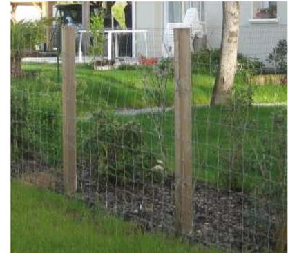
**Exemple** d'une clôture galvanisée sur poteaux carrés
