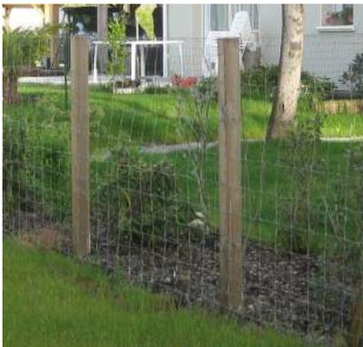
Exemple d'une clôture galvanisée sur poteaux carrés
