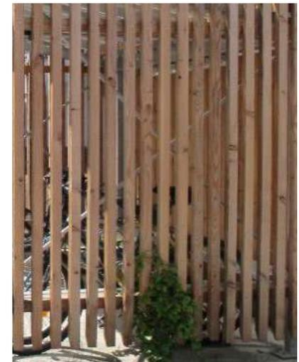
^ Exemple de bardage bois permettant l'intégration d'éléments techniques © ASP
