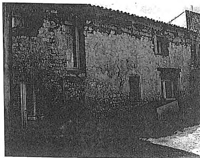
Condamnation et modification de portes et fenêtres Découpage des vitrages inadaptés
