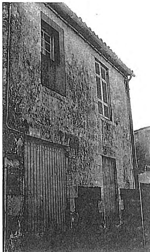
Condamnation et modification de portes et fenêtres Découpage des vitrages inadaptés
