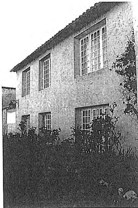
Le non-respect des dimensions des baies, des techniques traditionnelles (création de linteaux ou jambages en béton, appuis saillants,)
