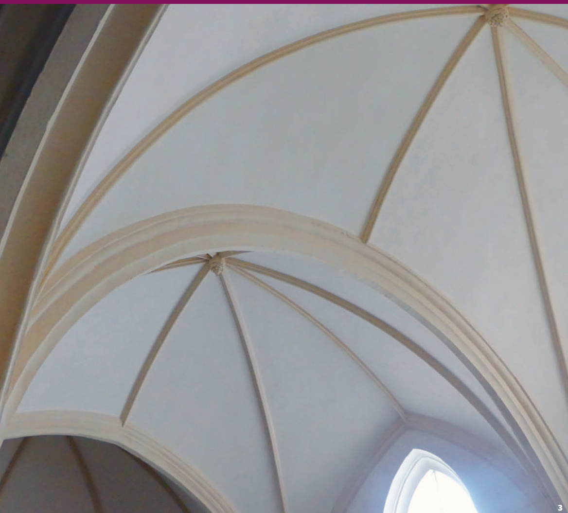
1. Détail de motif du pavage © M. Bompard 2. Cartouche portant la signature des charpentiers Michenaud et Gaillard et du plâtrier Martin, ainsi que la date de 1864 © M. Bompard 3. Nervures des voûtes de la nef © M. Bompard
